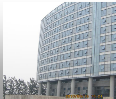
京津商务中心南塔
